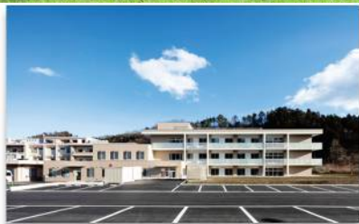
特別養護老人ホーム仙台敬寿園 仙台市青葉区下愛子田中 1-3
